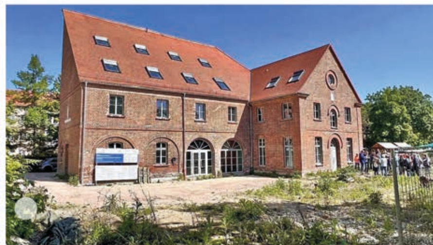
Die Südfassade des sanierten Wirtschaftsgebäudes vom Palais Hilda. Das Gebäude war ursprünglich ein Winkelbau. Den Zwilingsbau gibt es nicht mehr. (Foto: Thomas Ruttke)
