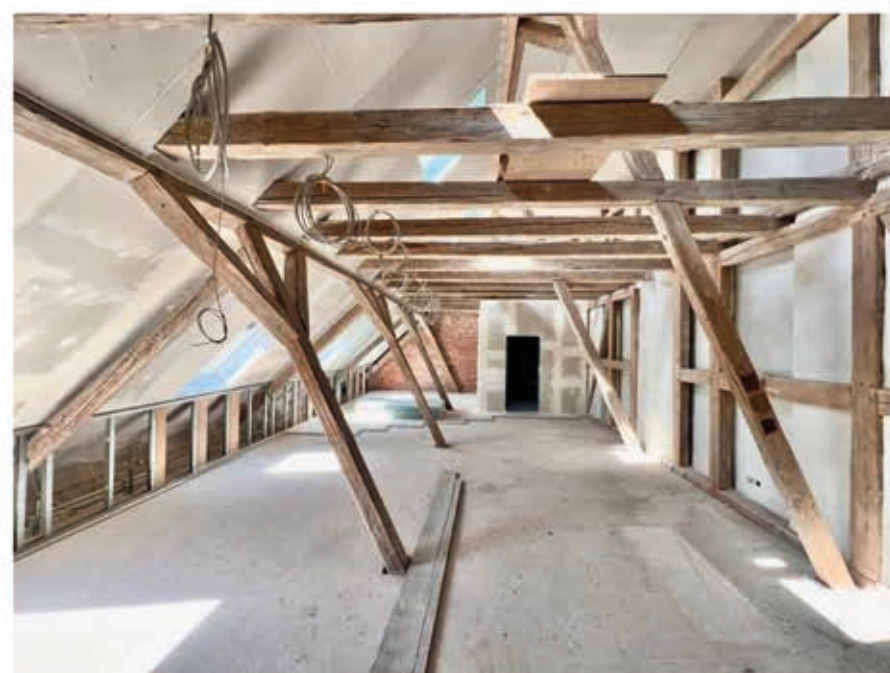
Das künftige Dachgeschoss. (Foto: Thomas Ruttko)
