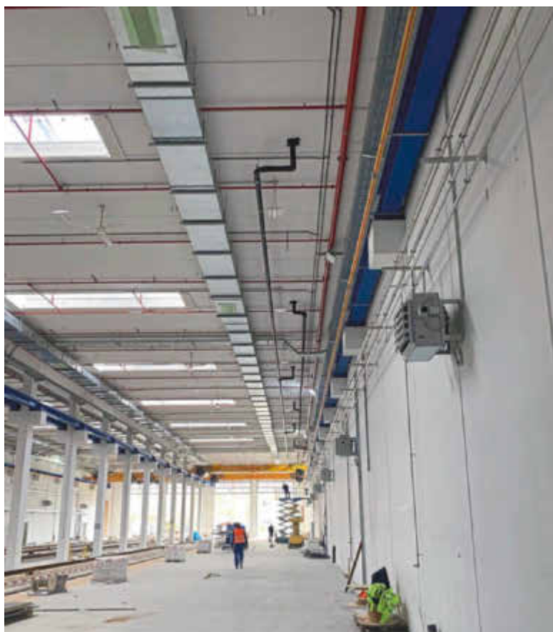
Brandschutz unter Retentionsdach: Notentwässerung mit SitaFireguard Gullys, ausgeführt als DSS-System.
