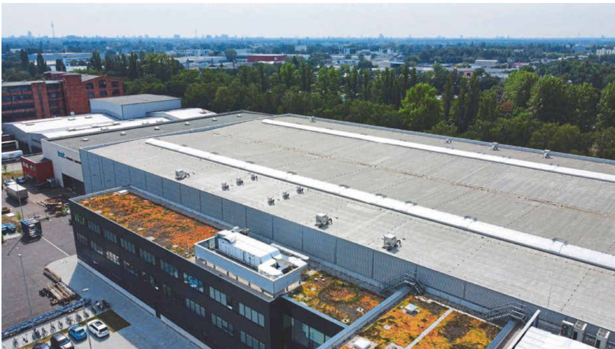
14.000 m 2 Dach über der Montagehalle, ausgestattet mit leistungsstarker Druckströmungsentwässerung.
